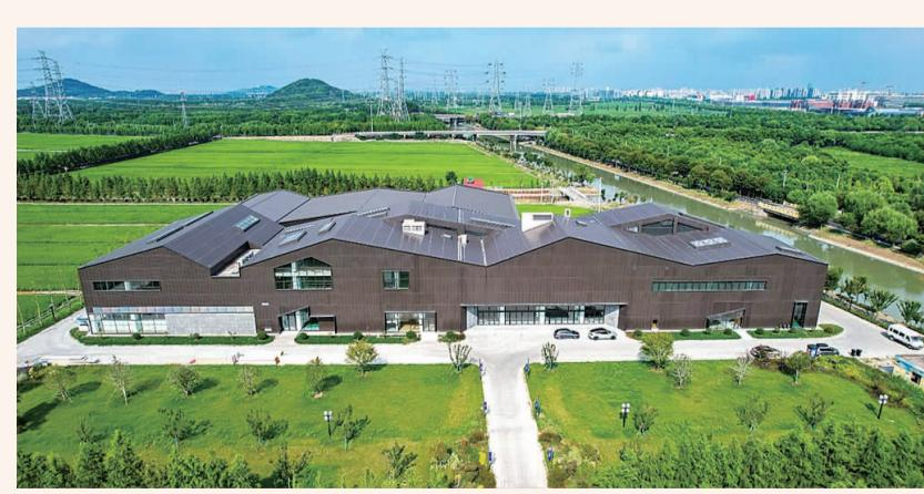
作为小昆山镇的重点项目，位于周家浜村的优质稻米保鲜库建设项目按计划推进中，目前正在设备安装调试工作，预计九月中旬正式完工并投入使用。据了解，该项目主要建设包括近3000平方米仓库及配套仓库排水设施、680平方米水泥场地、绿化工程、电力设施等，及15990立方米冷库。其中冷库分隔为4个库房，1#、2#、3#库房占地面积550平方米，净高6米，以稻谷为测算物，每个库房储藏量为750吨；4#库房占地面积740平方米，库房储藏量为1000吨，整个库的总储藏量为3250吨。建成现代化、规模化的稻谷、大米恒温储存基地，以“松江大米”产业的兴旺，助力乡村振兴战略的实施。（新民晚报）
